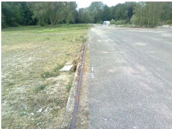
afbeelding 9. asfaltverharding en deel kraanbaan oost van havens
