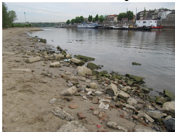
afbeelding 16. puin in kribvakken west van John Frostbrug
