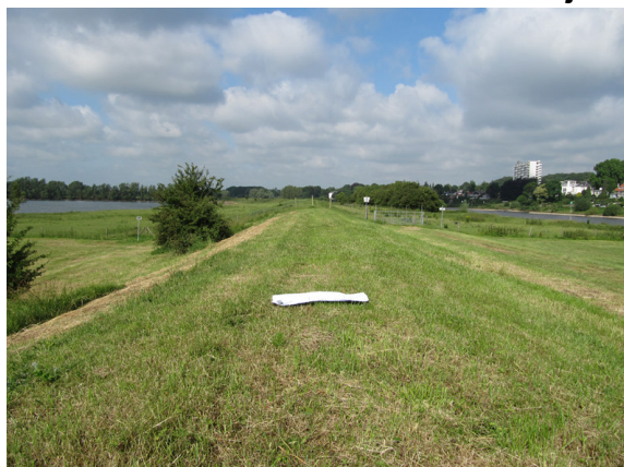
afbeelding 29. dijk tussen plas van Bruil en steenfabriek Meinerswijk
