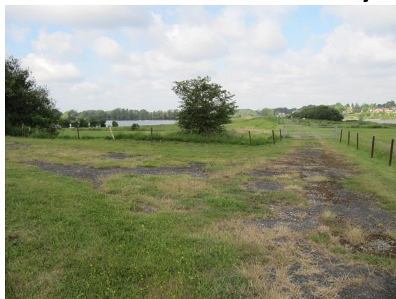
afbeelding 30. dijk tussen plas van Bruil en steenfabriek Meinerswijk
