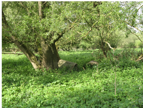
afbeelding 44. betonnen duikers aan maaiveld
