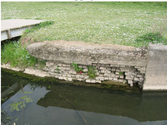
afbeelding 31. losse stenen in kade bij bruggetje
