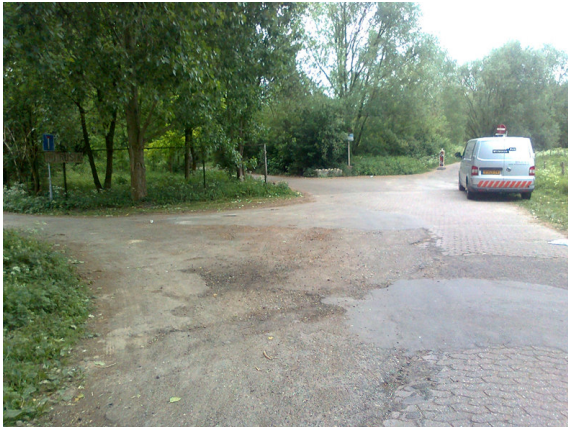
afbeelding 1. asfaltverharding kruising Stadsblokkenweg
