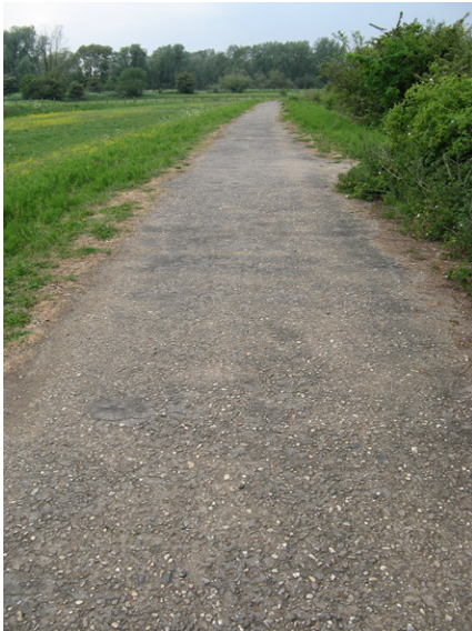
afbeelding 19. asfaltweg op dijkje ri zuiden (zuidkant plas van Bruil)
