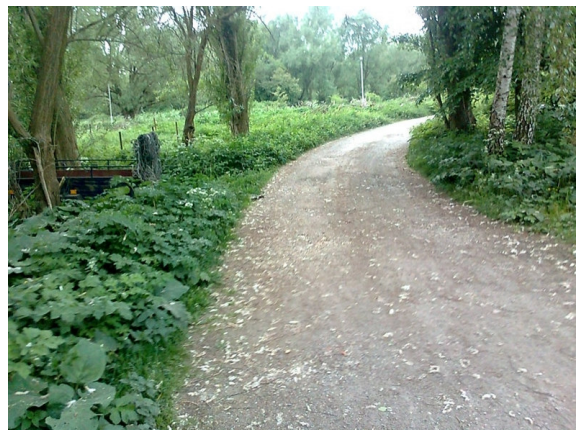
afbeelding 4. puinverharding nabij haven van Coers
