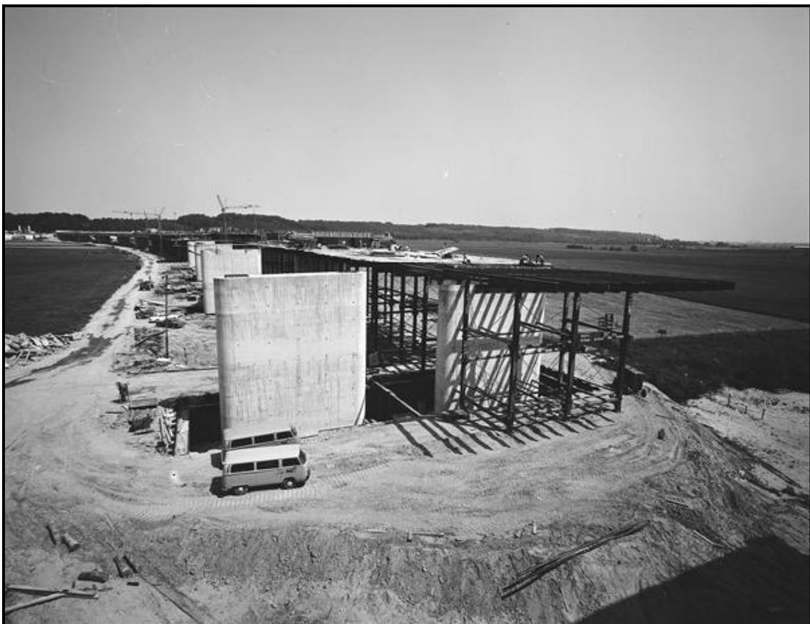
Figuur 2.3 Aanleg fundering pijlers in bouwkuip [5]
