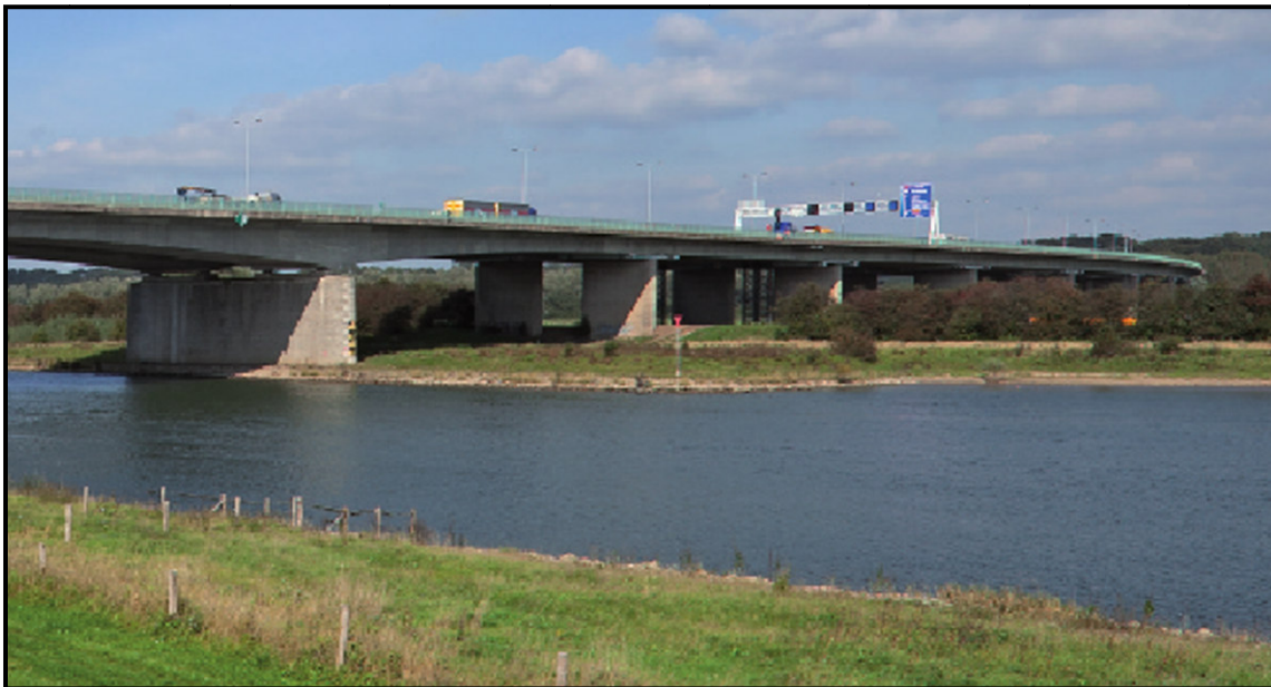
Figuur 2.1 Aanzicht verkeersbrug en pijlers noordelijke oever vanaf de zuidoever [5]
