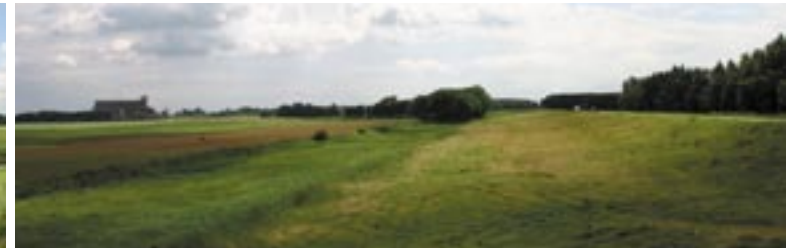
opgave: verleggen van de Deltadijk
