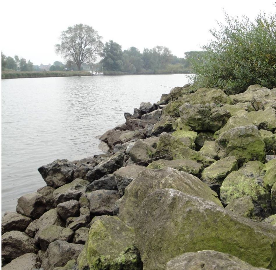
Foto B.1: Oeververdediging langs de westelijke gelegen oever in de bocht bij Woudrichem
