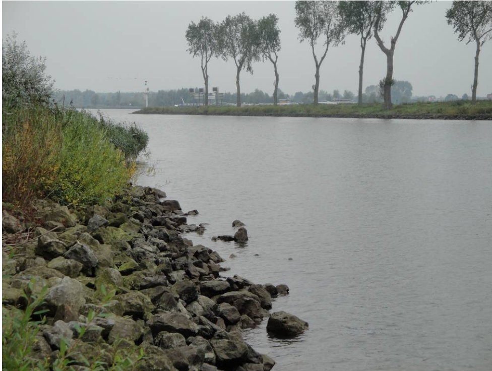
Foto B.3: Geleidingswerk langs de Afgedamde Maas met de bomenrijen voor de zichtbaarheid
