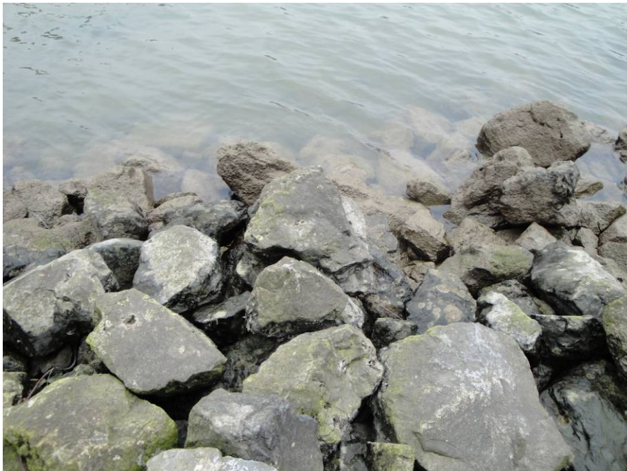
Foto B.2: Oeververdediging langs de westelijke gelegen oever in de bocht bij Woudrichem
