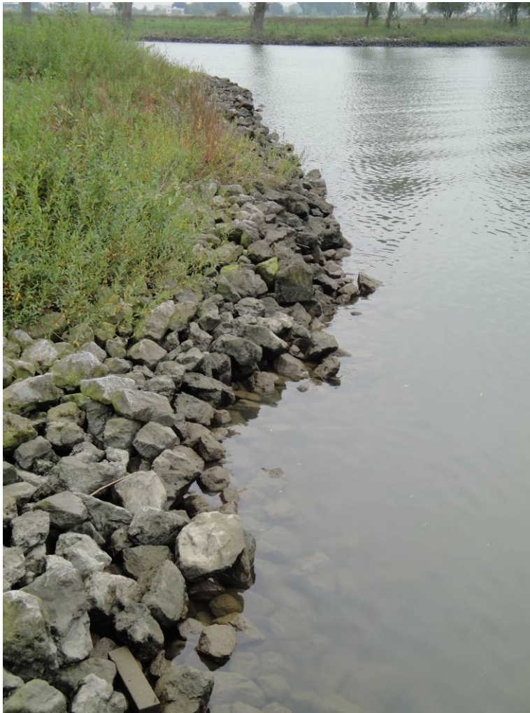
Foto B.5: Oeververdediging in de binnenbocht van de Afgedamde Maas
