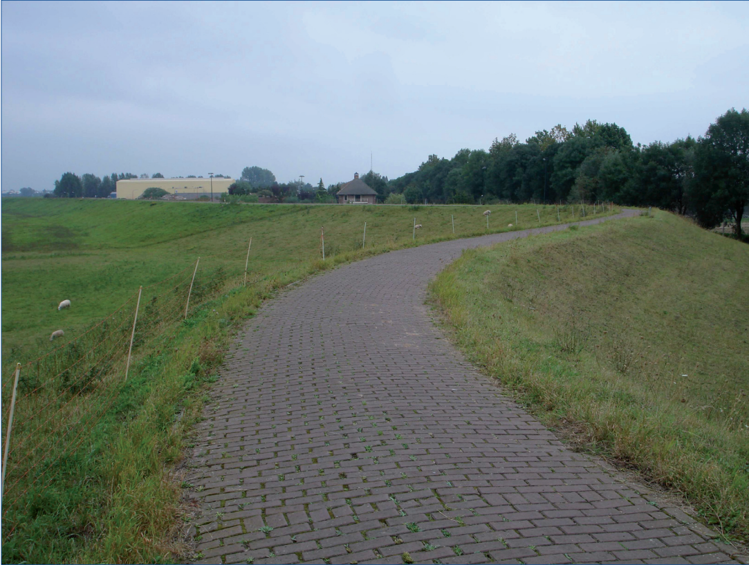
Figuur 9. Een bocht in de Millingse Bandijk ter plaatse van een verdwenen kolk (foto: Luuk Keunen).
