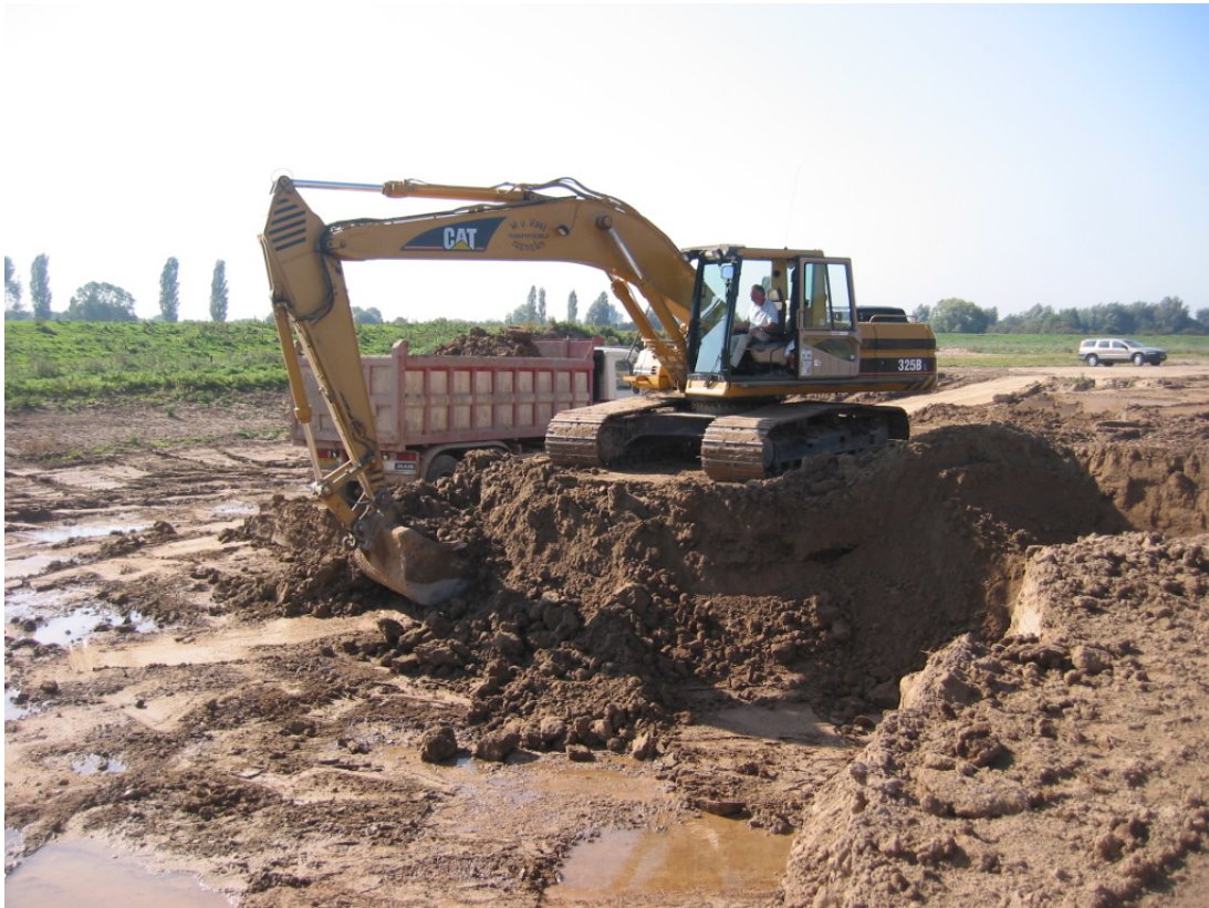
Figuur 16: Reliëfvolgende afgraving van eeuwenlange kleiafzettingen tot op de zandige ondergrond. Bij ongewijzigde inrichting van de uiterwaard (hoge kades, lage stroomsnelheden bij hoogwater) zal kleisedimentatie opnieuw het dominante morfologische proces worden. Foto Jos Rademakers, 2006
