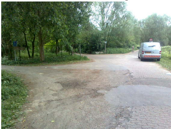
afbeelding 1. asfaltverharding kruising Stadsblokkenweg
