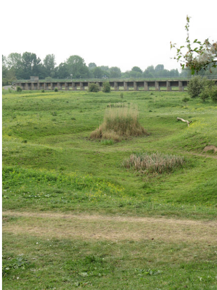
afbeelding 33. doorlaatwerk vanaf noordoosten
