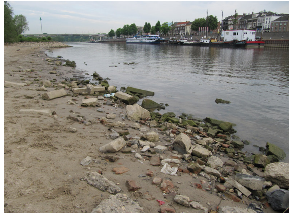
afbeelding 16. puin in kribvakken west van John Frostbrug
