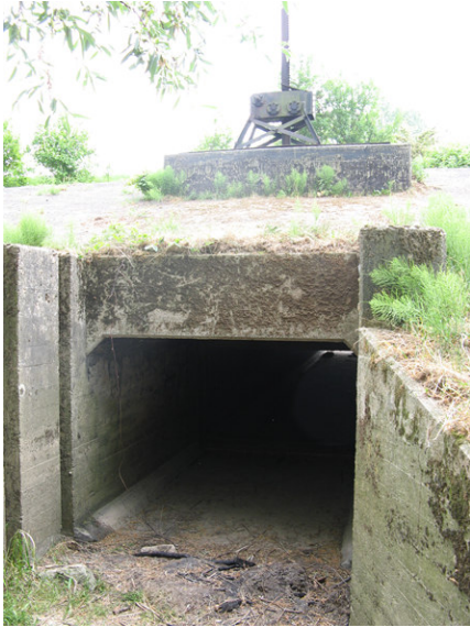
afbeelding 27. inlaat aan westkant Meginhardweg
