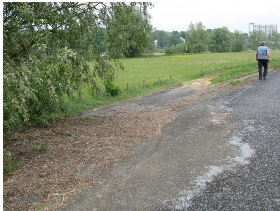
afbeelding 26. asfaltverhard talud
