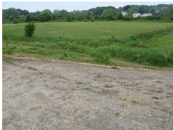
afbeelding 24. asfaltverhard talud
