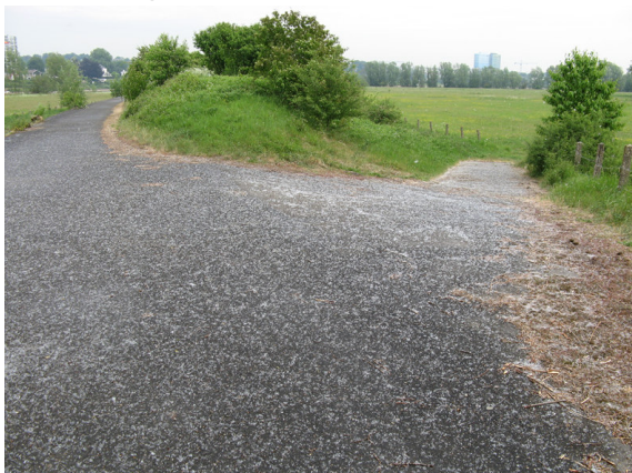
afbeelding 25. asfaltverhard talud
