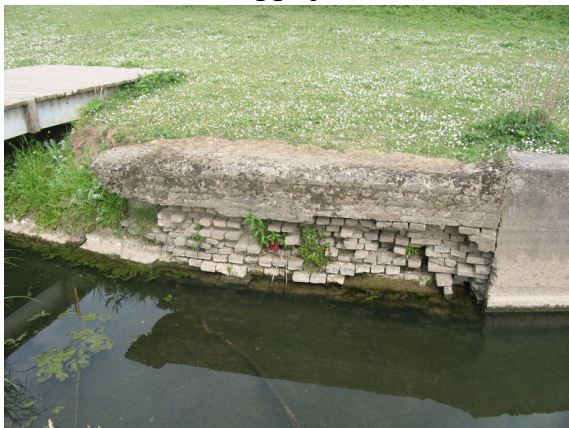
afbeelding 31. losse stenen in kade bij bruggetje
