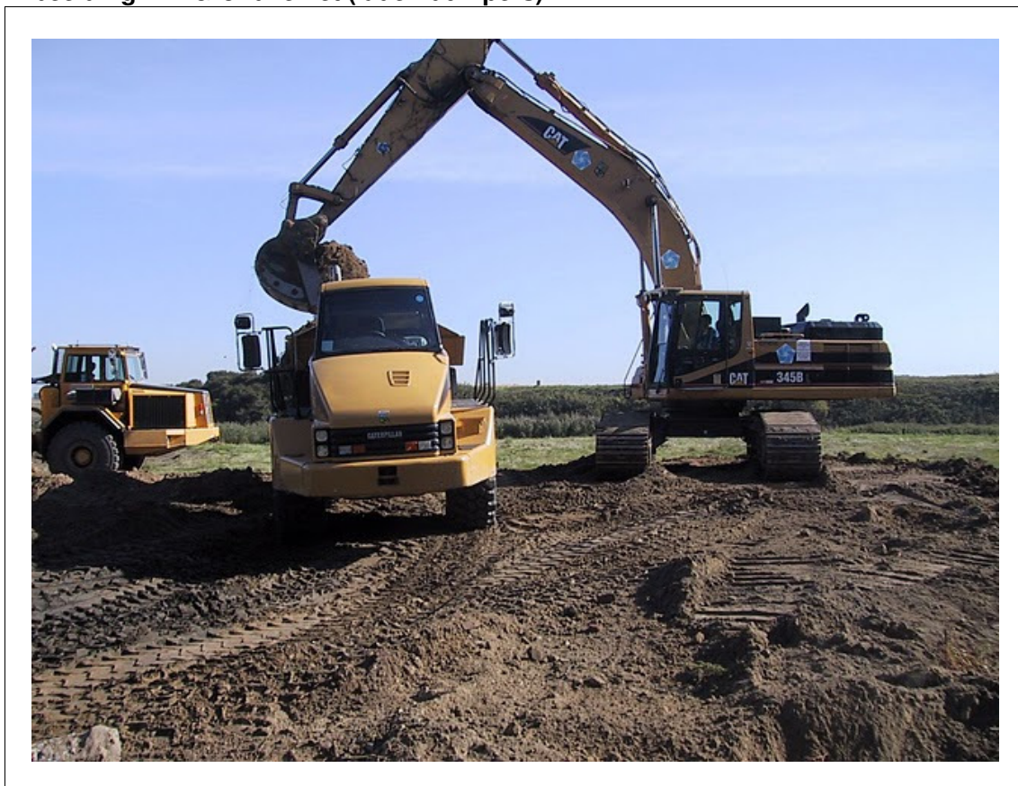
Afbeelding 4.2. Grondverzet (laden dumpers)
